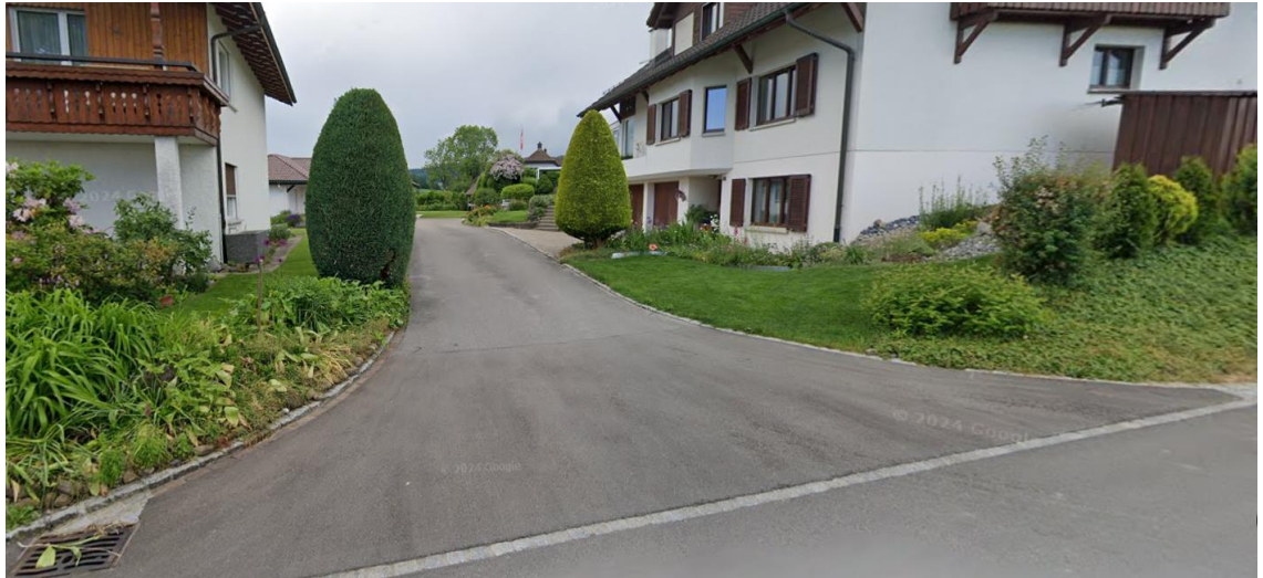
Abbildung 14: Beckensteinweg, geringe Strassenbreite (3.80 m) ohne Kreuzungsmöglichkeit PW-PW, geringe Sichtbarkeit des Rechtsvortrittes wegen Wasserstein (Quelle: Google Street View)
