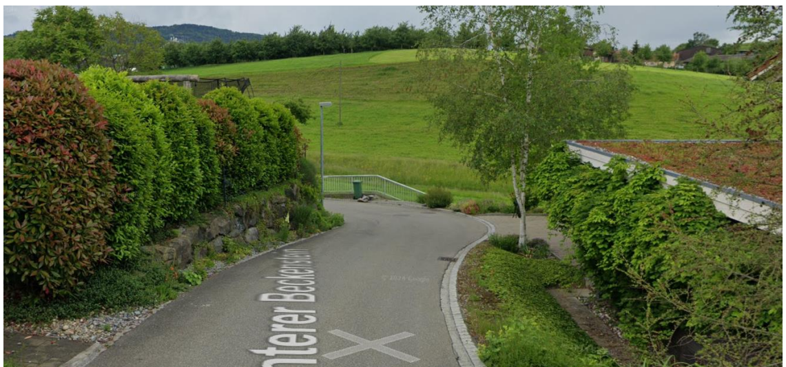
Abbildung 13: Unterer Beckenstein, unübersichtliche Kurve bei geringer Strassenbreite (4.00 m) mit eingeschränkter Kreuzungsmöglichkeit (LW-PW nicht möglich, PW-PW mit Schrittempo) (Quelle: Google Street View)
